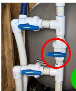
**Bien positionner les valves du BYPASS** afin que l'appareil soit prêt à être démarré lorsque qu'une montée en température de l'eau de la piscine sera souhaitée.
