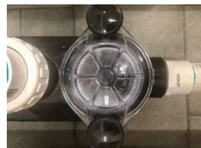
12. **Tout doit bien être hermétique** : Vérifier le serrage des raccords et le joint d'étanchéité du couvercle de la pompe afin que ce dernier soit bien positionné.
